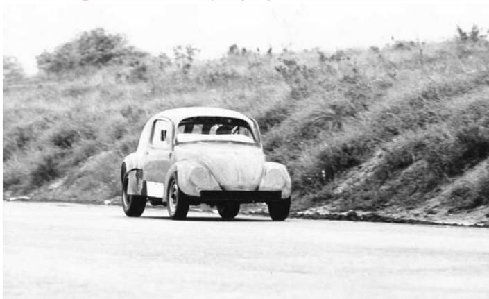
**O primeiro teste na pista de Interlagos, ainda com pneus finos e a frente de fibra sem acabamento**
